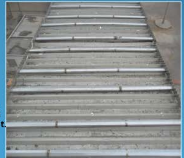
PROTEÇÕES ANTE-POMBOS SOBRE COBERTURAS, MUROS COM FIOS EM ARAME DE INOX TOTALMENTE TENCIONADOS.
